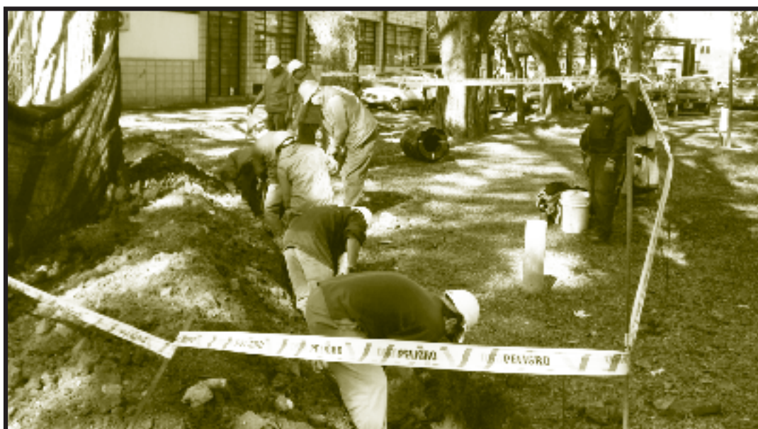
Con los ecoductos se entubaron 10 metros de una zanja cerca de la Facultad de Informática.
